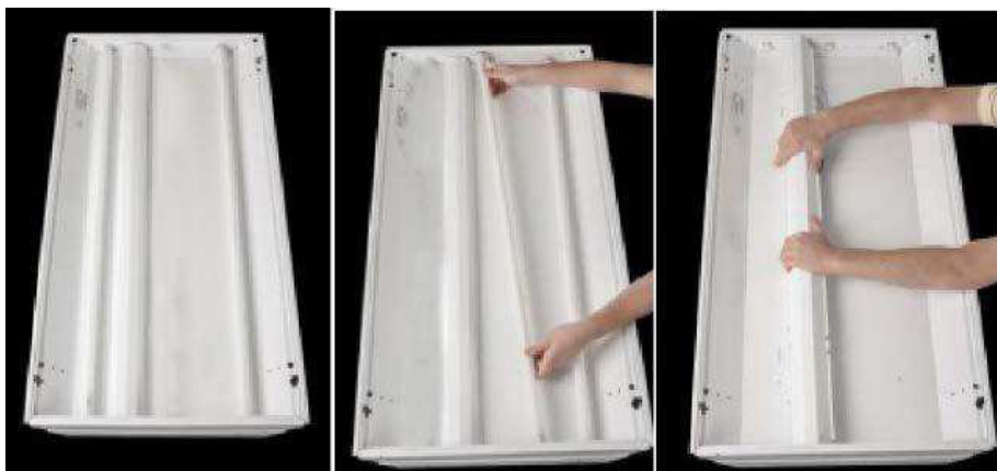
a) Troffer y lámparas b) Retire las lámparas tubulares c) Retire la cubierta del balasto (lente retirada)
